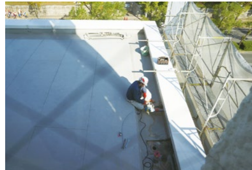
壁外に排水するため、新たに壁に穴をあけています
