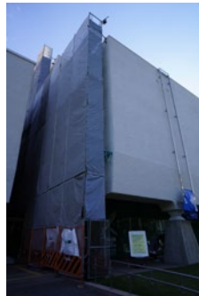
隣接する原田の森ギャラリーとの隙間に設けられた足場
